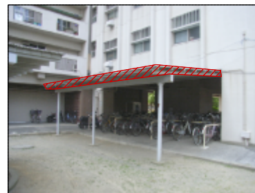
自転車置場屋根 撤去復旧
