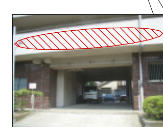
出入口上部 落下防止養生設置
